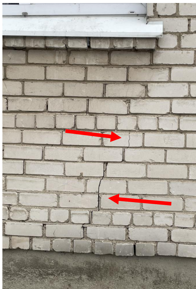
Pav. 8. Sienų defektai: vertikalūs plytų mūro įtrūkimai.
