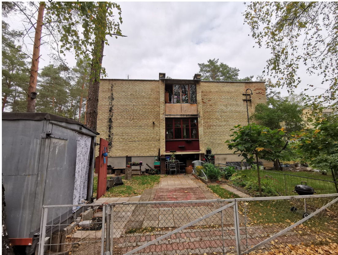
Fasadas iš gatvės pusės
