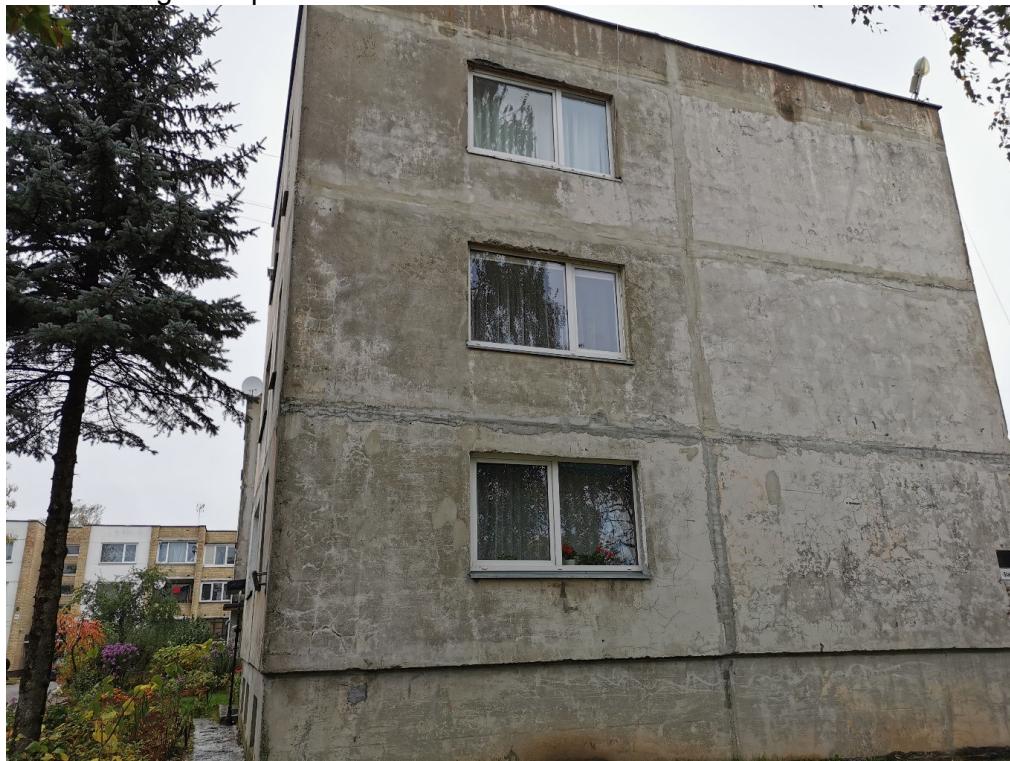
Fasadas iš gatvės pusės
