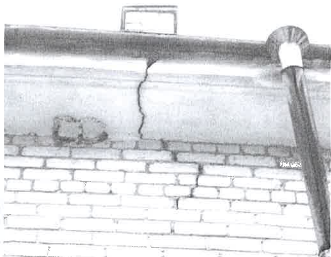
4 pav. Plytų mūro, karnizo trukimų fragmentas.
