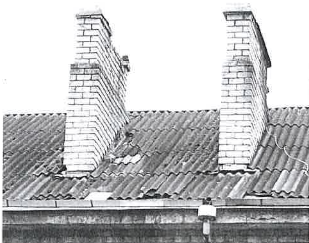
1 pav. Stogo, kaminų būklės fragmentas.
