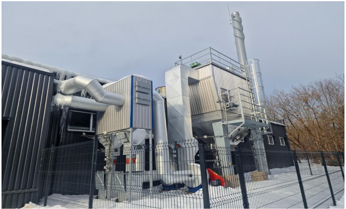
5 pav. Buivydiškių k. katilinės rekonstrukcija įrengiant 2 biokuro granulinius po 1 MW katilus
