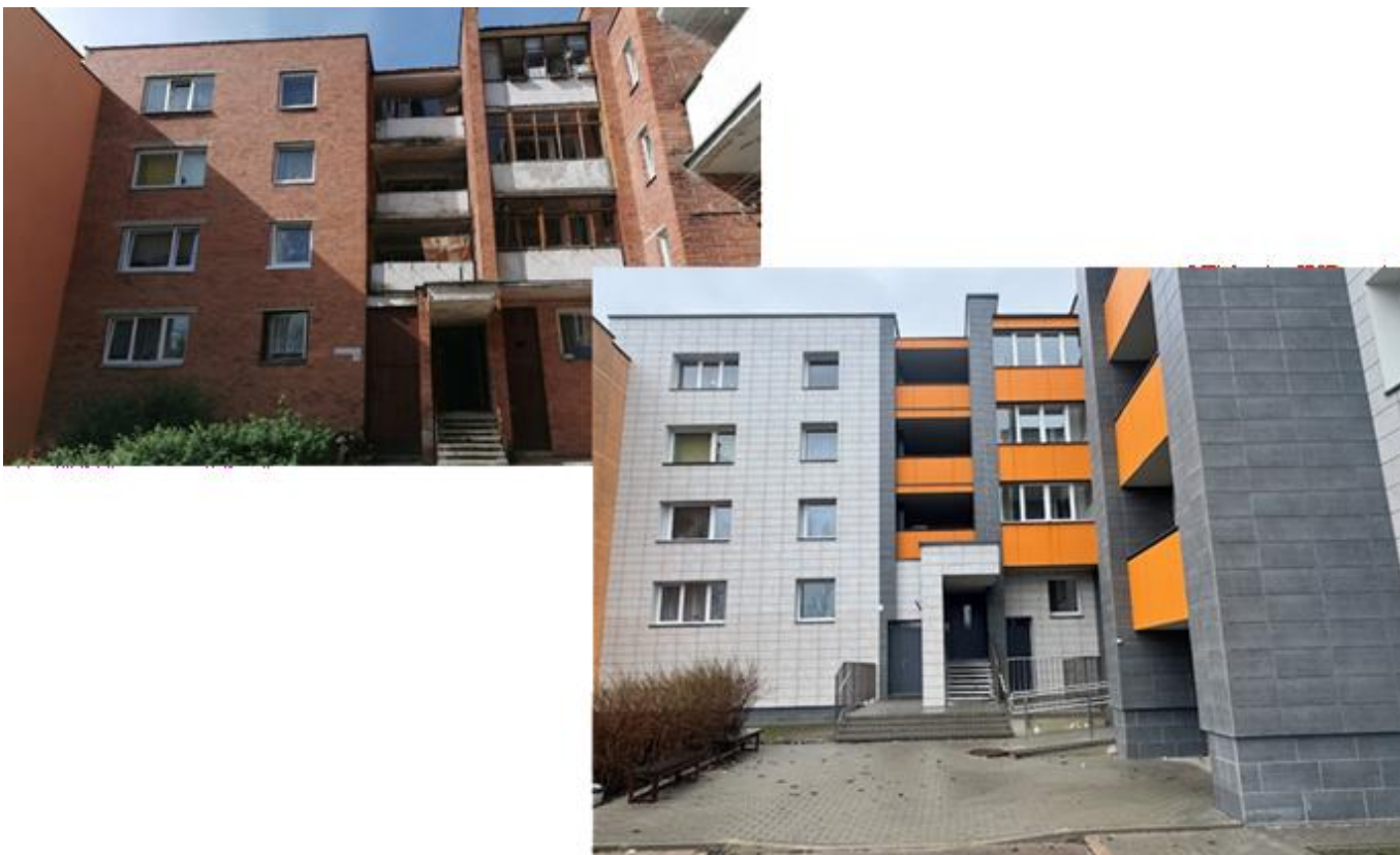
5 pav. Šv. Mykolo g. 7 ir Šv. Mykolo g. 9, Nemenčinės m. atnaujinimo (modernizavimo) darbai prieš ir po
