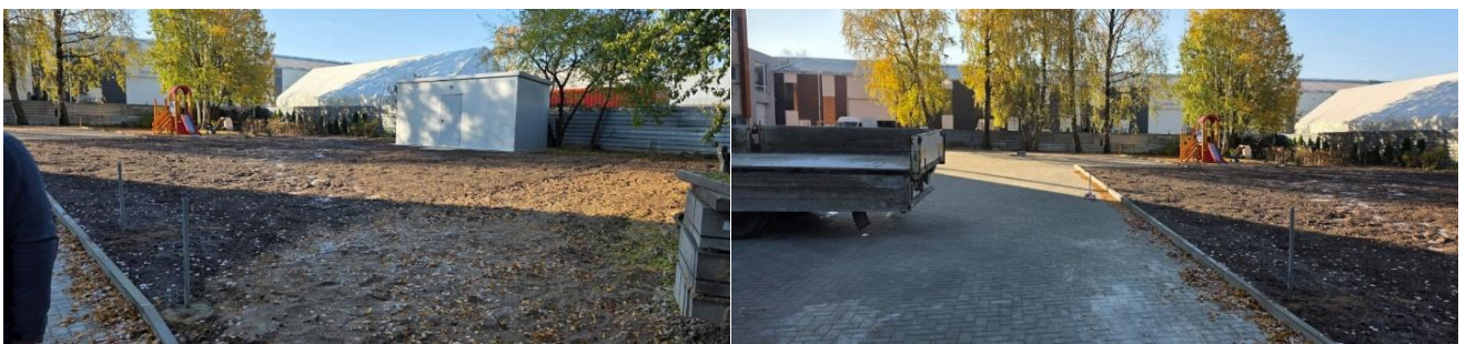
1 pav. Gėlių g., Avižienių mstl., Avižienių sen. - vandens gerinimo įrenginiai
