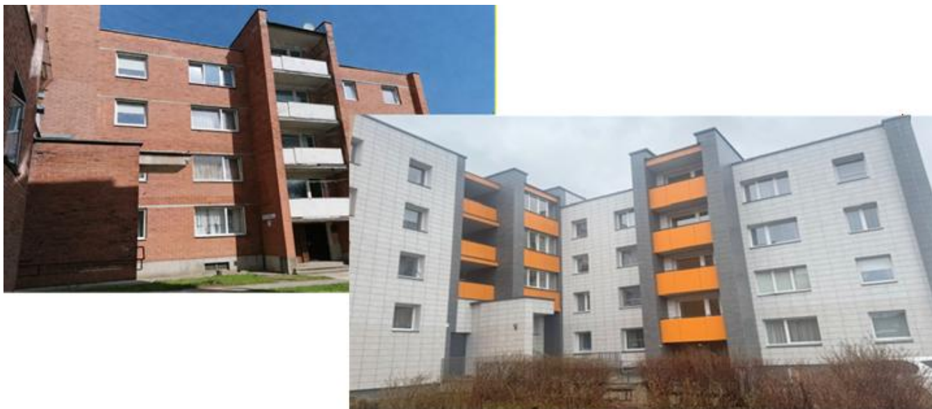
6 pav. Šv. Mykolo g. 7 ir Šv. Mykolo g. 9, Nemenčinės m. atnaujinimo (modernizavimo) darbai prieš ir po
