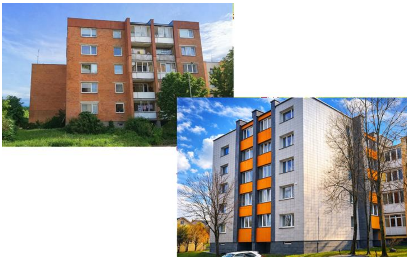
7 pav. Šv. Mykolo g. 7 ir Šv. Mykolo g. 9, Nemenčinės m. atnaujinimo (modernizavimo) darbai prieš ir po
