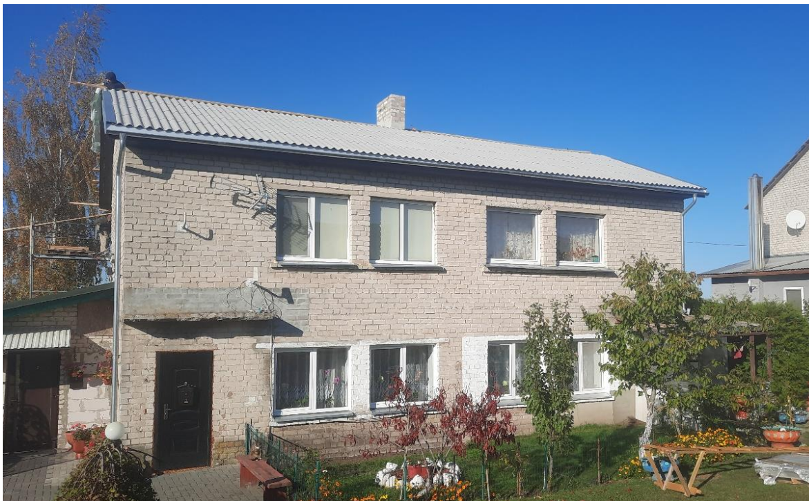
7. Didžioji g. 35, Visalaukės I k., Paberžės sen. stogo remonto darbai. VRSA dalis - 9 283,94 Eur
