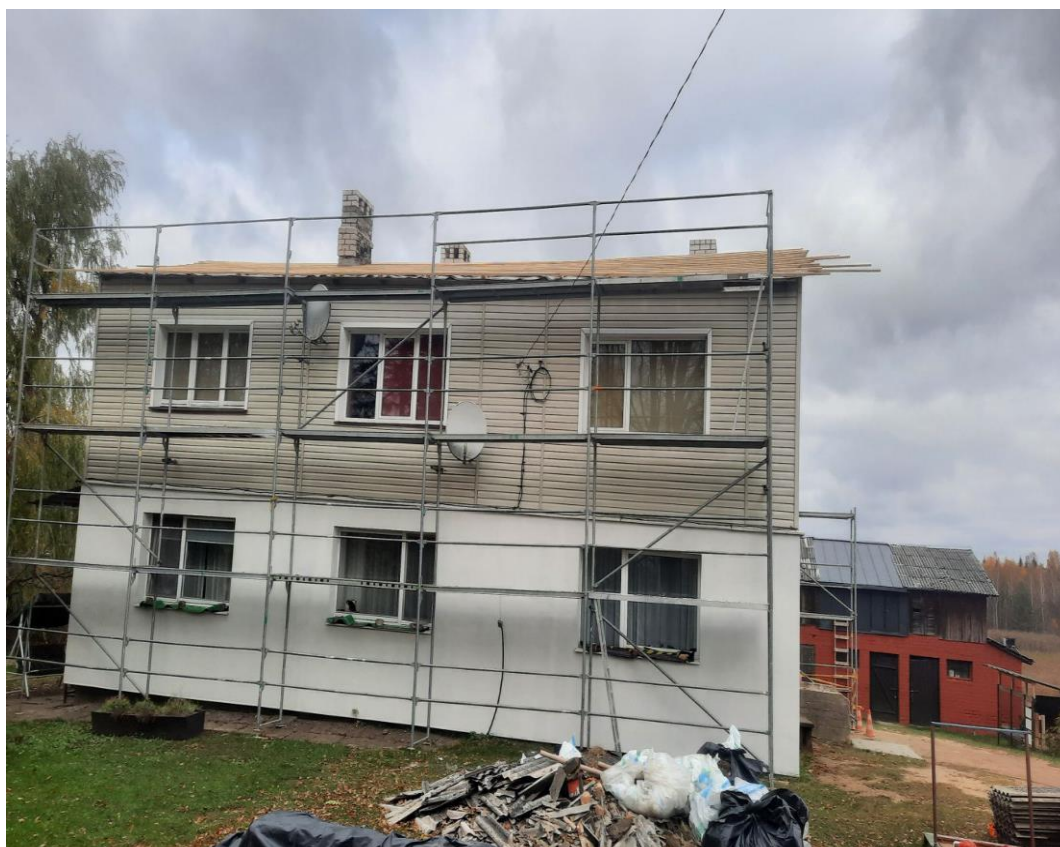
4. Bažnyčios g. 17, Eitminiškių k., Nemenčinės sen. stogo remonto darbai, VRSA dalis - 17 818,19 Eur
