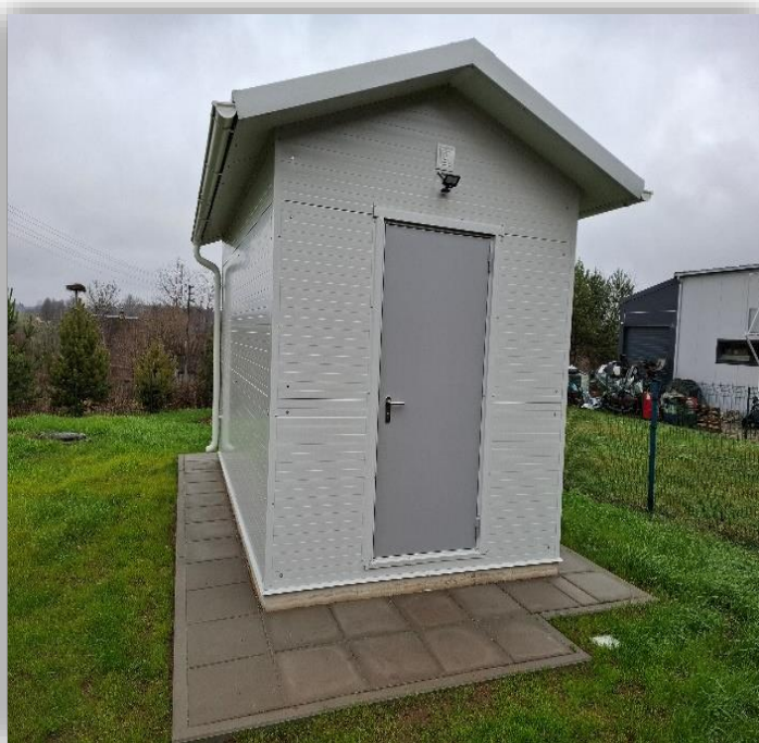
1 pav. Beržų g., Riešės k. vandens gerinimo įrenginiai
