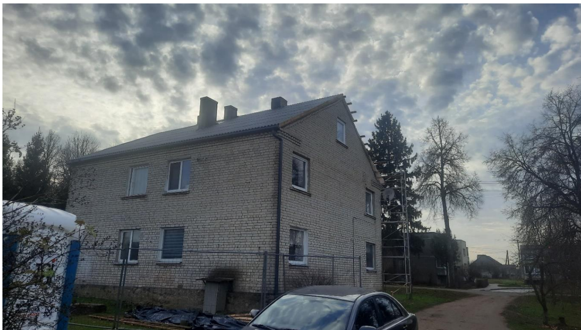
3. Liepų al. 14, Glitiškių k., Paberžės sen. šlaitinio stogo remonto darbai. VRSA dalis – 9 540,78 Eur
