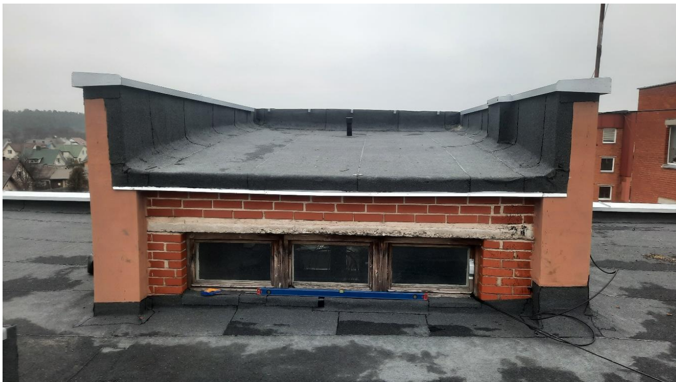
10. Šv. Mykolo g. 10, Nemenčinė stogo remontas įrengiant pašiltinimo sluoksnį. Gyventojų lėšos – 14 918,07 Eur
