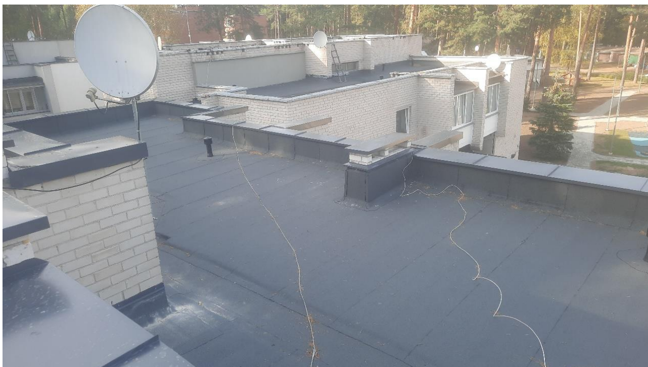
8. Taikos g. 2B, Kreivalaužių k., Nemenčinės sen. stogo remontas įrengiant pašildinimo sluoksnį. VRSA dalis – 17 397,30 Eur
