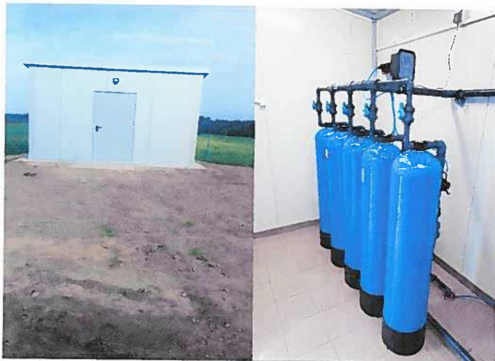
2 pav. Padabčių k. vandens gerinimo įrenginiai
