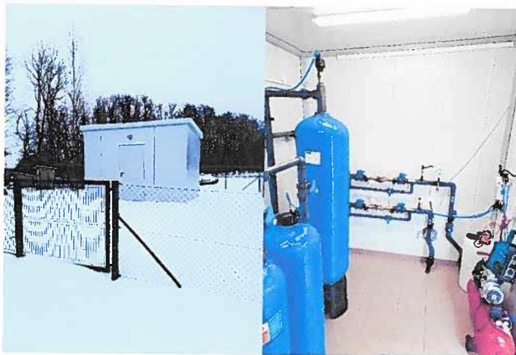
1 pav. Kiaušiadalos k. vandens gerinimo įrenginiai
