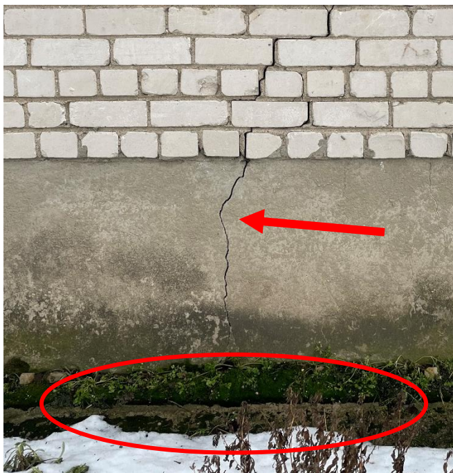
Pav. 7. Cokolio ir nuogrindos defektai
