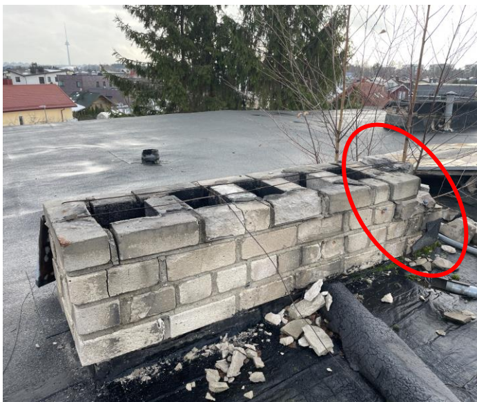
Pav. 11. Stogo defektai: apgriuvusios ir neapskardintos vėdinimo šachtos
